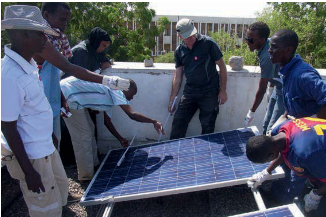
Montage einer Photovoltaik-Schulungsanlage in Dschibuti unter der Leitung der Firma Hoffman und Ollinger aus Mettlach (Bildmitte Stefan Ollinger)
