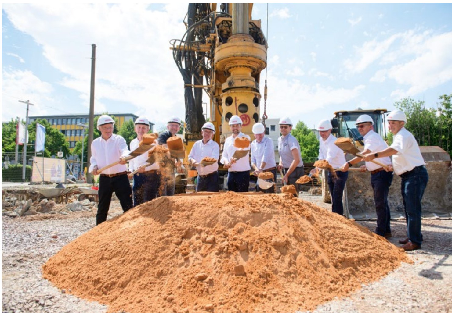
Symbolischer Spatenstich für die neue Bildungsstätte der Handwerkskammer (v.l.n.r.): HWK-Präsident Bernd Wegner, HWK-Hauptgeschäftsführer Bernd Reis, HWK-Projektleiter Gordon Haan, Jürgen Lenhof (Ministerium für Wirtschaft, Innovation, Digitales und Energie), der Saarbrücker Oberbürgermeister Uwe Conradt, Siegmund Ahr (Architekturbüro Ahr), Andreas Kepper (Bundesministerium für Wirtschaft und Energie), Jens Bentfeld (Gerber Architekten) und die HWK-Vizepräsidenten Holger Kopp und Peter Becker Foto: Jennifer Weyland
