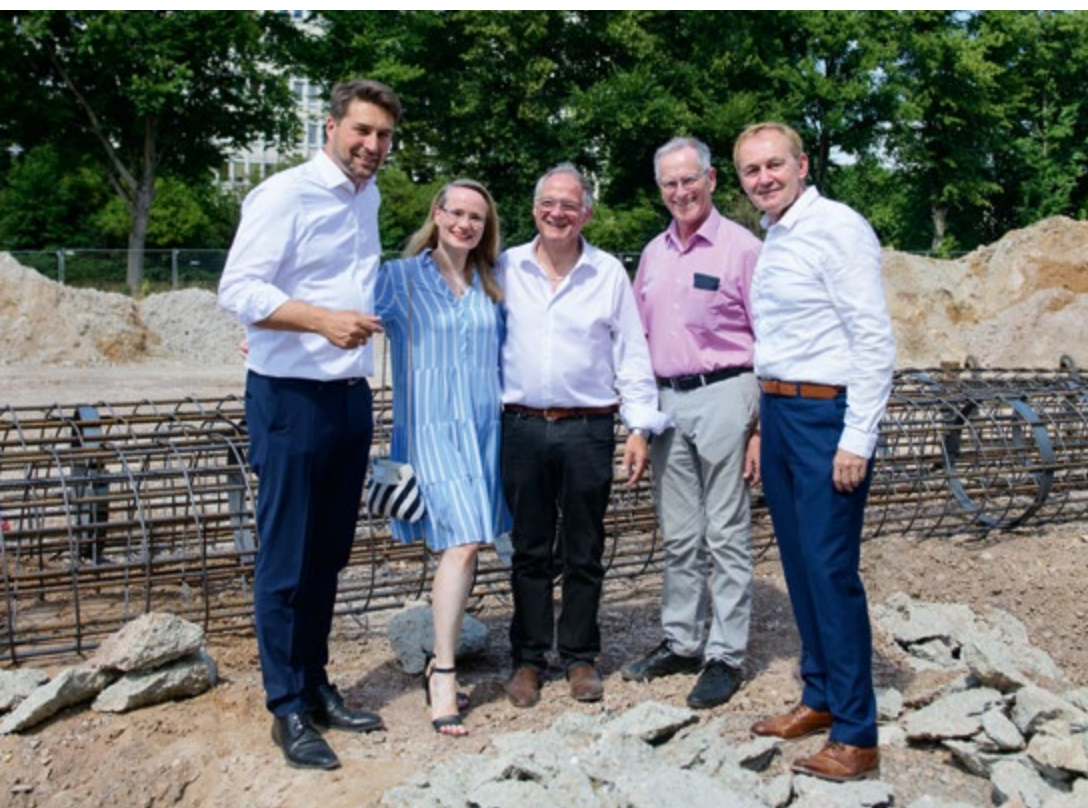
Beim Spatenstich auf dem Baugelände (v.l.n.r.): der Saarbrücker Oberbürgermeister Uwe Conradt, die damalige Landtagsabgeordnete Gabriele Herrmann, HWK-Präsident Bernd Wegner, der damalige bau- und verkehrspolitische Sprecher im Stadtrat der Landeshauptstadt Saarbrücken Hermann Hoffmann sowie HWK-Hauptgeschäftsführer Bernd Reis Foto: Jennifer Weyland
