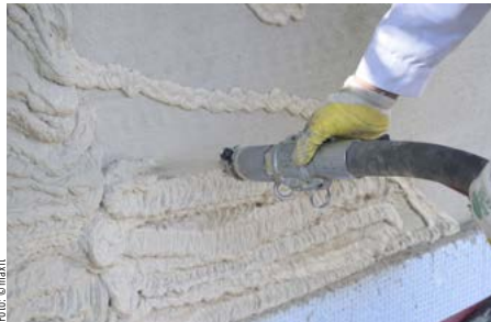
Die spritzbare Hochleistungsdämmung Ecosphere in der Anwendung.
